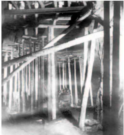
Holzausbau eines Stollens
