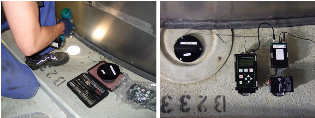
Abbildung 4: Installation eines akustischen Erfassungsgerätes (hier batcorder der FA. ecoObs, Erlangen) mit Scheibenmikrofon und GSM-Modul am Boden einer Gondel. Links ist das Loch erkennbar, durch das das Mikrofon nach außen und unten gerichtet wird. Foto: B. Gessner
